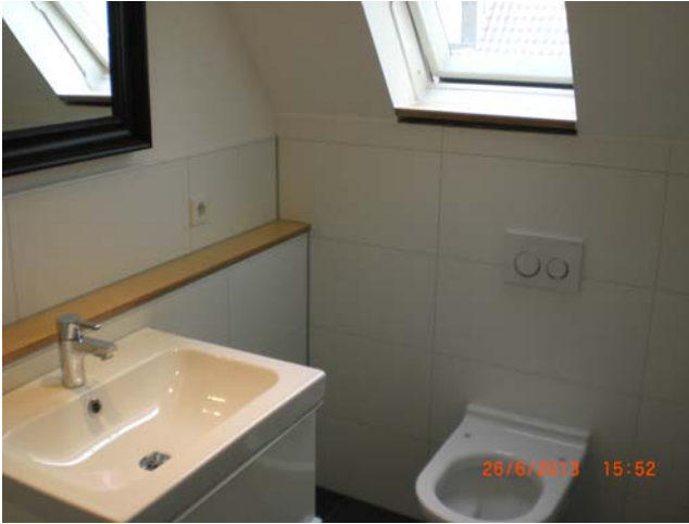
Modernisierung einer Toilettenanlage
