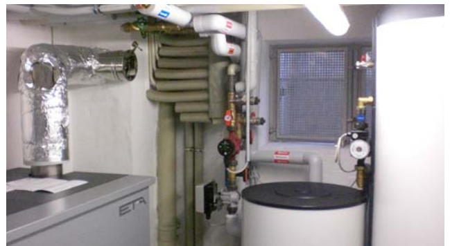
Kesselerneuerung mit Umstellung von Heizöl auf Holzpellets auf engem Raum
