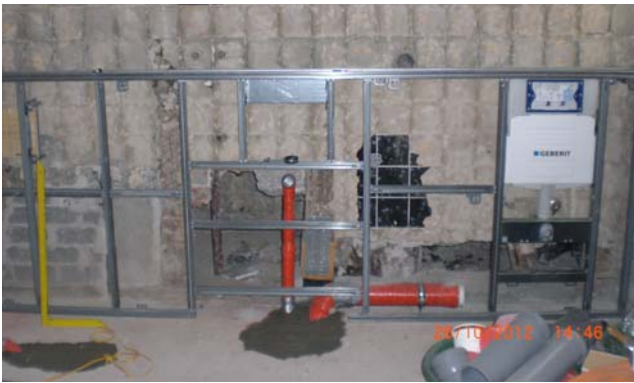
Badmodernisierung mit Vorwandinstallation
